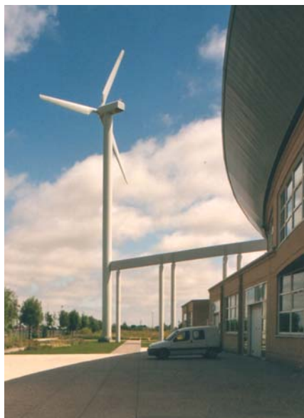
L'éolienne du lycée Léonard de Vinci à Calais (62), avec une puissance de 13,2 kW produit 200 000 kWh par an.
