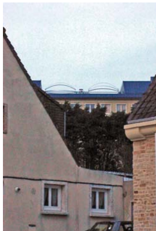
L'éolienne horizontale sur le toit d'un immeuble d'habitation à Equihen-Plage (OPAC du Pas-de-Calais) permet de couvrir les besoins en électricité des parties communes de 40 logements d'une résidence.
