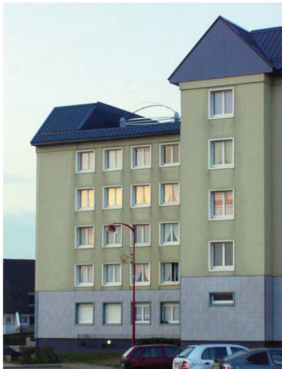
L'éolienne horizontale sur le toit d'un immeuble d'habitation à Equihen-Plage (OPAC du Pas-de-Calais) permet de couvrir les besoins en électricité des parties communes de 40 logements d'une résidence.
